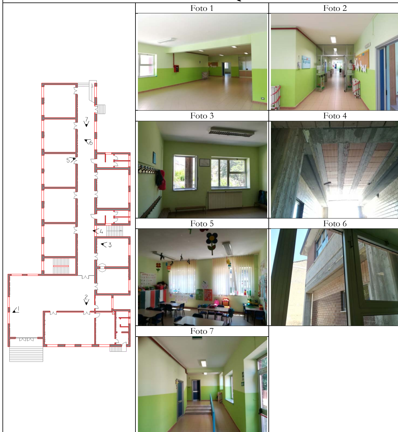
Figura 2 Rilievo fotografico piano terra
