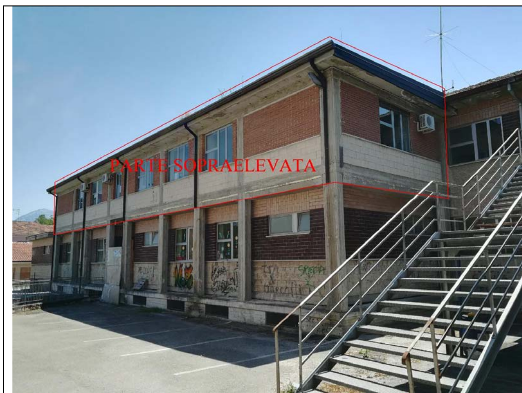
Figura 2.4 Vista esterna del fabbricato con indicazione della parte sopraelevata
