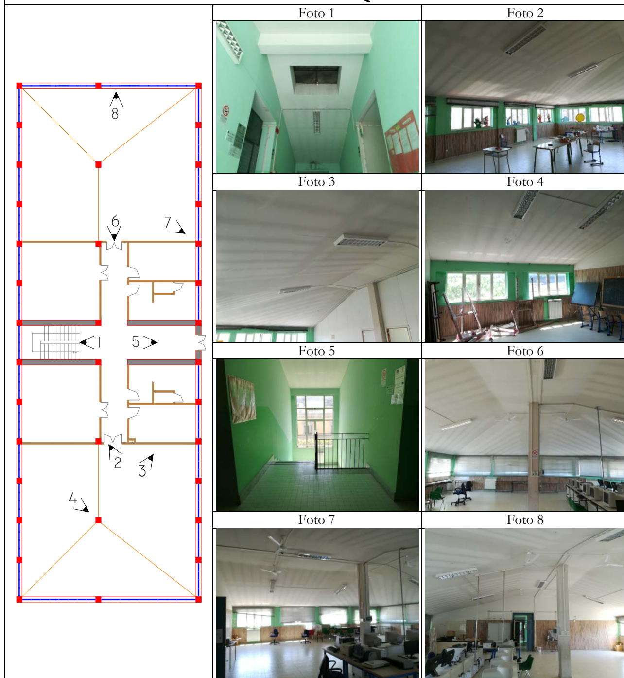
Figura 7 Rilievo fotografico piano sottotetto
