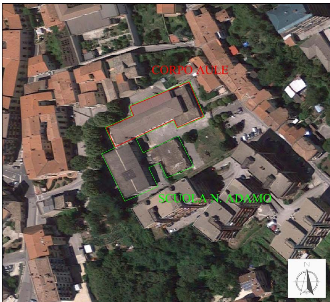
Figura 2.1 - Vista aerea del plesso scolastico “N. Adamo”
