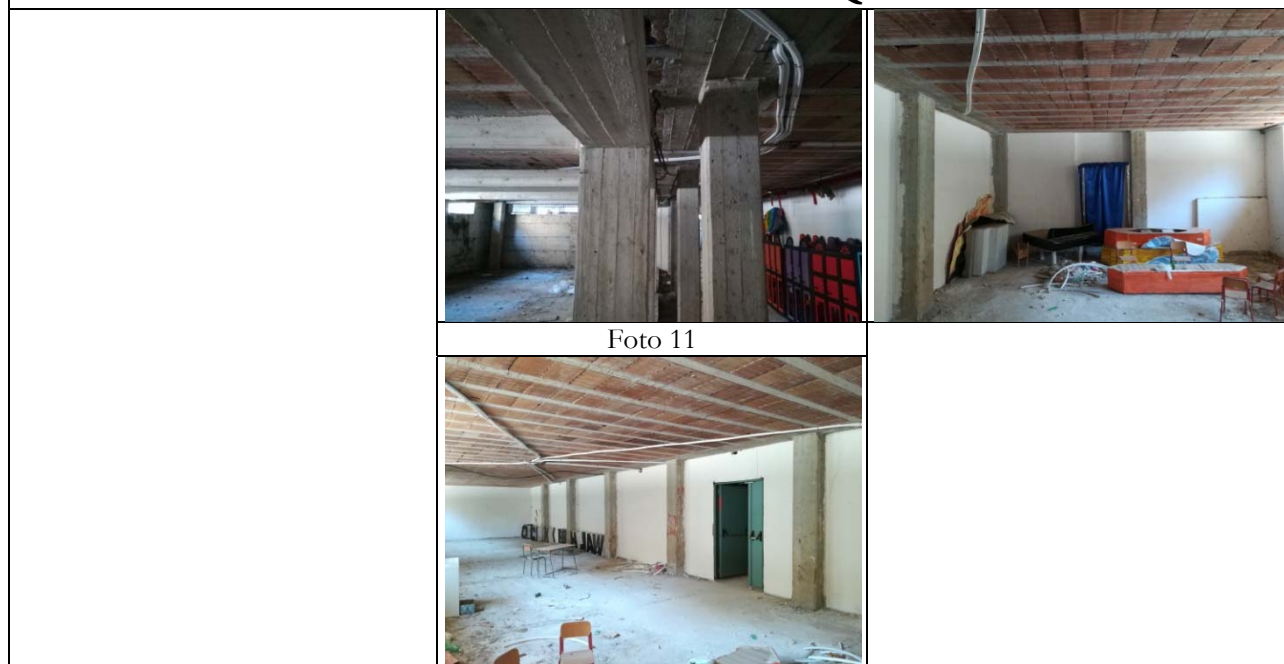
Figura 1 Rilievo fotografico piano seminterrato
