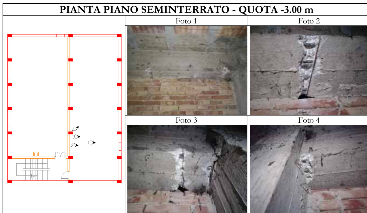
Figura 3.3 Saggi sulla trave centrale del seminterrato
