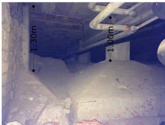
Figura 3.1 Misurazione altezza pilastri al di sopra dei plinti
