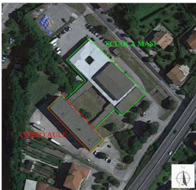
Figura 2.1 - Vista aerea del plesso scolastico "R. Masi"
